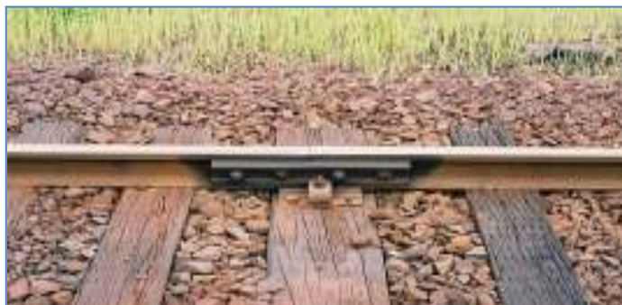
Gambar 15 : Sambungan Menumpu
